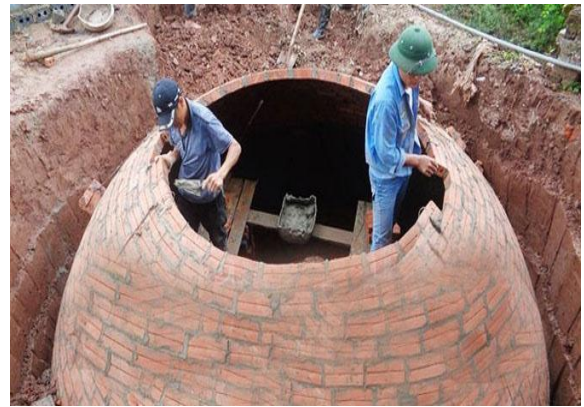
Hầm Biogas xây bằng gạch
